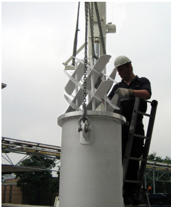
Abb. 1 Einbau von statischen Mixern in einen Rohrreaktor der Nennweite DN800
